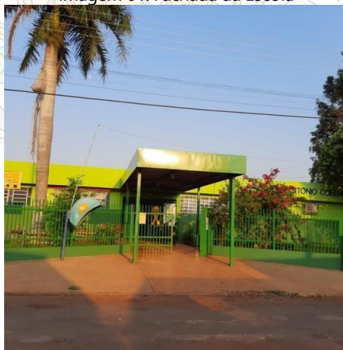
Imagem 01: Fachada da Escola
